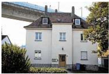
Straßenansicht des gemeindlichen Mietshauses Würzburger Straße 58 FOTO: DIETER GÜRZ
